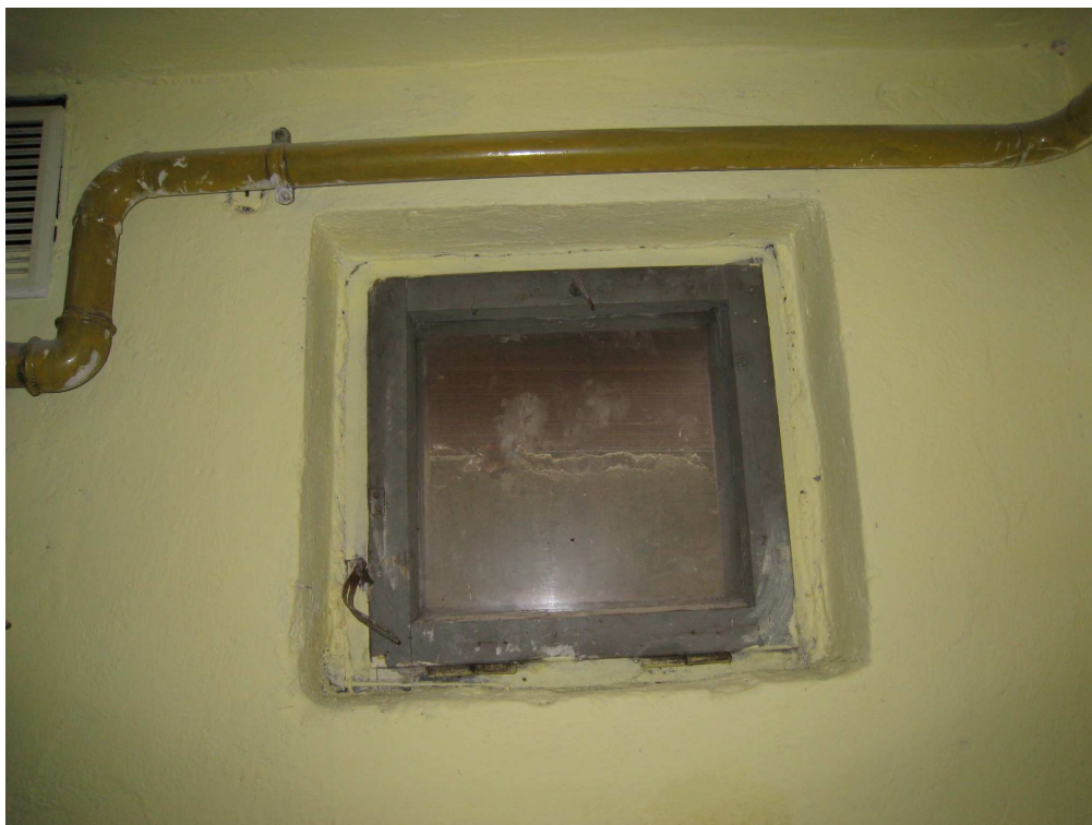
Zużyta stolarka okienna w piwnicy przewidziana do wymiany (wymiary i kształt stolarki pozostawić bez zmian).
