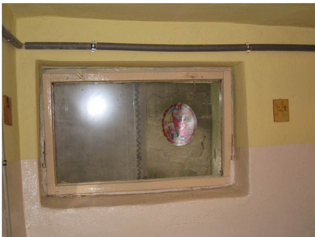
Zużyta stolarka okienna w piwnicy przewidziana do wymiany (wymiary i kształt stolarki pozostawić bez zmian).
