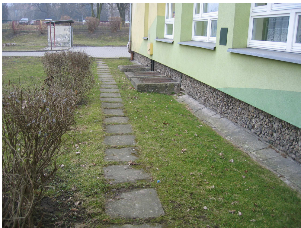
Istniejący cokół, naświetla piwnic oraz opaska budynku przewidziane do remontu
